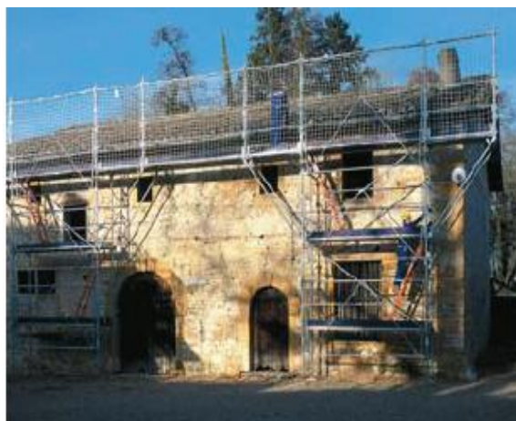
Plancher de travail sur sapines avec protection bas de pente Source : OPPBTP
